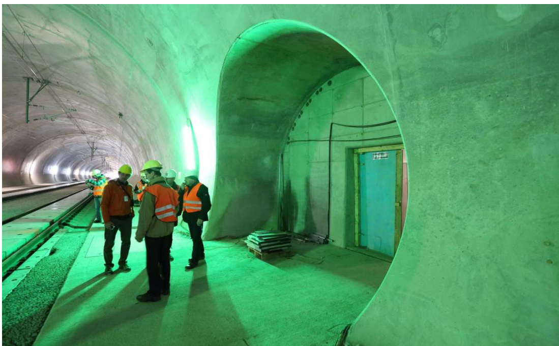
Obrázek 4: Únikový východ v tunelu Silberberg na NBS Ebendfeld - Erfurt
