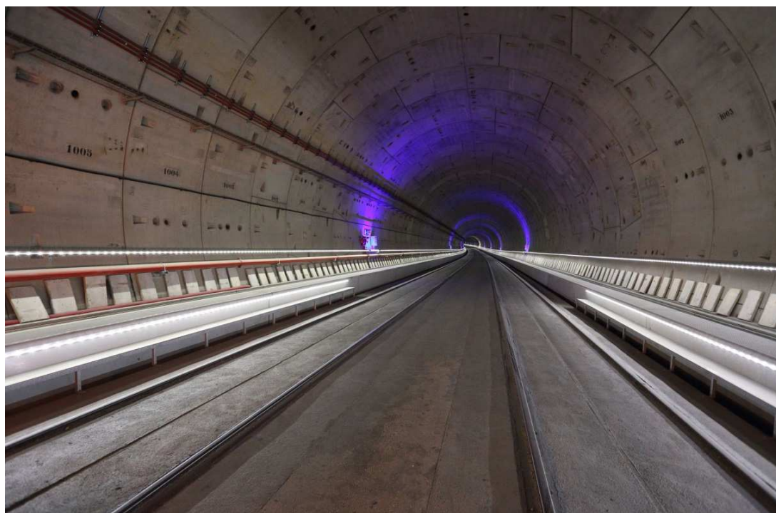
Obrázek 15: Dvoukolejný tunel vyražený pomocí TBM. Propojení nádraží v Madrid – Atocha a Madrid - Chamartín, pevná jízdní dráha
