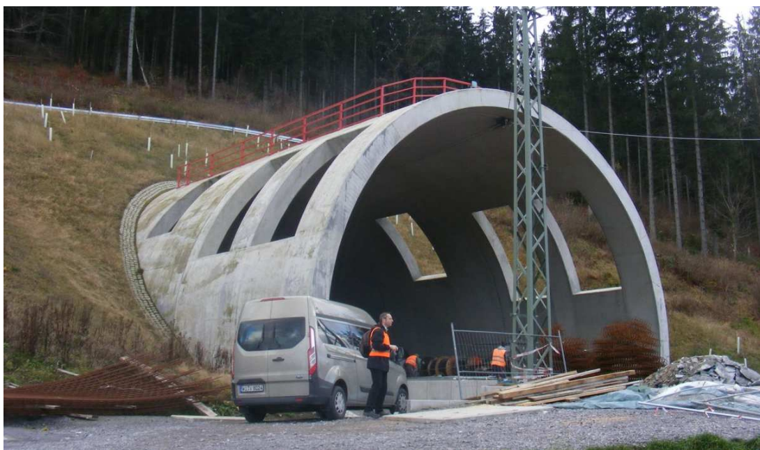
Obrázek 8: Úprava portálu proti akustickému třesku, dvoukolejný tunel Silberberg (NBS Ebensfeld – Erfurt, délka 7391 m)
