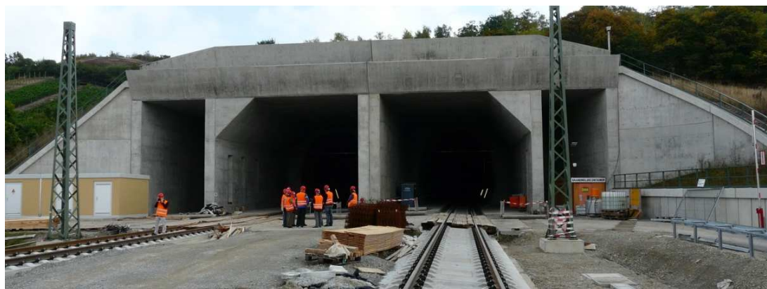
Obrázek 9: Úprava portálu proti akustickému třesku, Finne tunel (NBS Erfurt – Leipzig / Halle, délka 6965 m)
