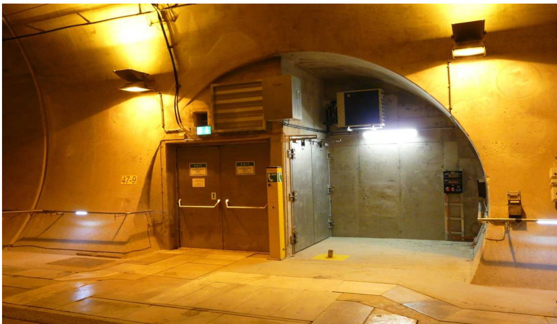
Obrázek 3: Únikový východ v tunelu Wienerwald na Westbahn, Vídeň – St. Pölten
