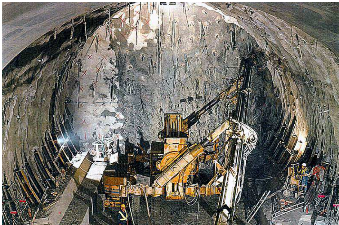
Obrázek 17: Tunelování metodou ADECO-RS
