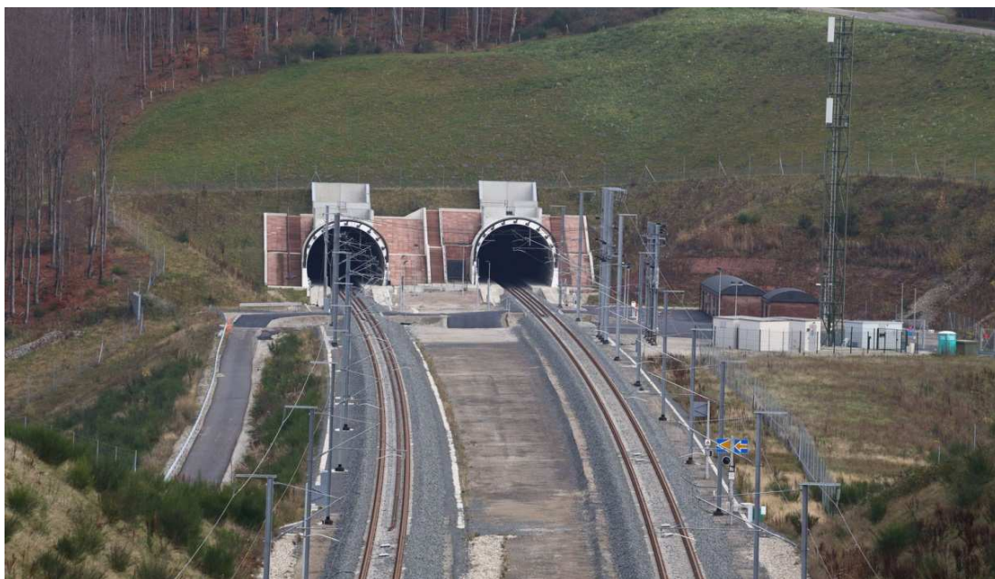
Obrázek 13: Portál dvou jednokolejných tunelů – tunel Saverne na VRT Strasbourg - Paris
