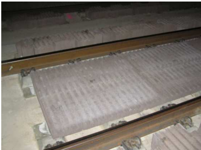
Obrázek 11: Instalované pohlcovače značky LIAKUSTIK, které vyrábí firma Bausteine Briest GmbH. Skládají se z expandovaného jílu s pórovitostí 25 % a průměrnou hustotou 1027 \text{ kg/m}^3 a proudovým odporem 9540 \text{ Pa/s.m}^2 . Na svrchní straně se nacházejí žebra vysoká 30 mm. Desky pohlcovačů mají tloušťku 150 mm a šířkou 1000 mm. Přídavné desky ještě kryjí venkovní části pražců. Pohlcovače jsou přilepeny k podloží.
